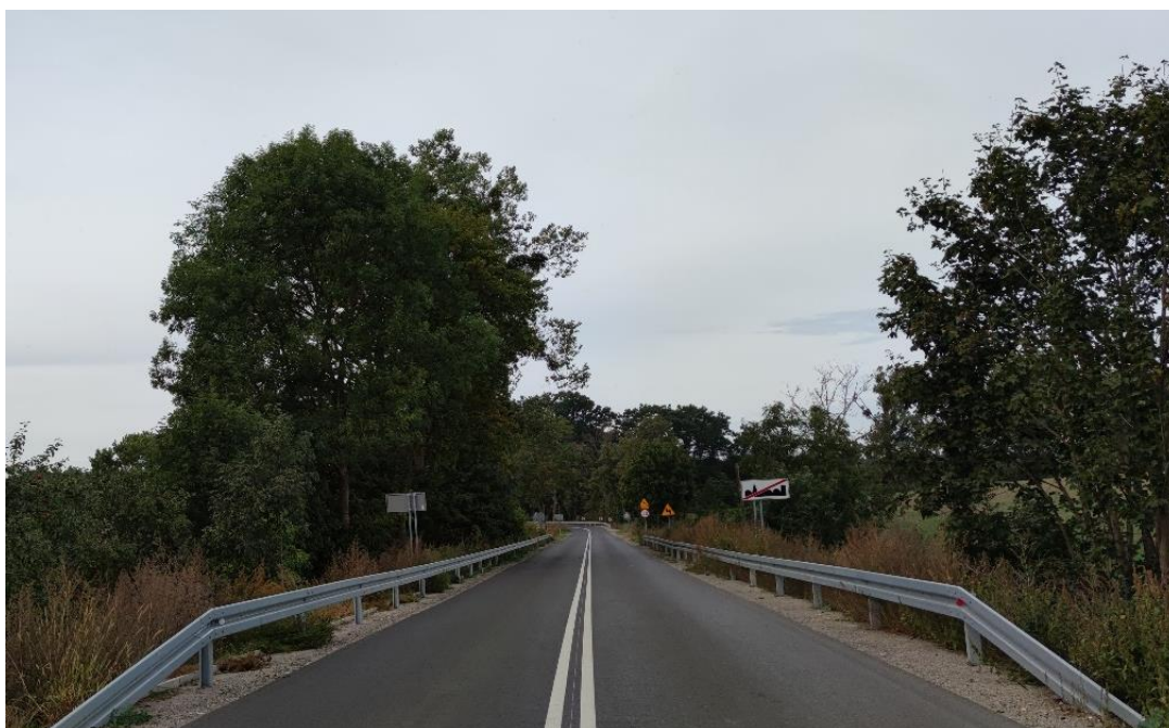
„Przebudowa drogi powiatowej nr 1048C Osie – Warlubie” dofinansowanej w ramach Rządowego Funduszu Rozwoju Dróg oraz środków z Funduszu Leśnego
