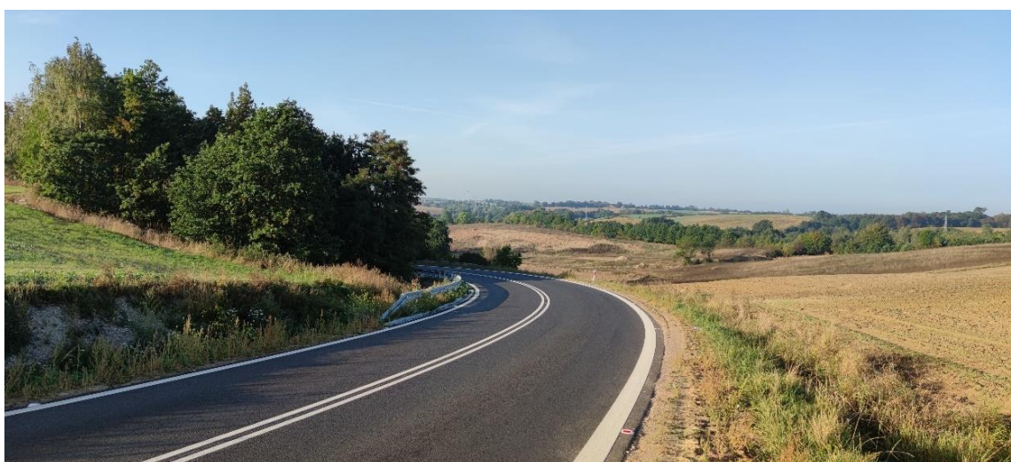
„Remont drogi powiatowej w miejscowości Gruczno.” dofinansowany w ramach Rządowego Funduszu Rozwoju Dróg
