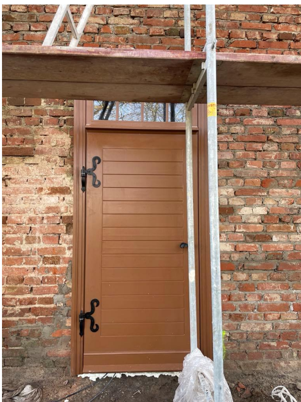
Fot. 18-21. Wykonano i wstawiono nowe drzwi, które były wzorowane na drzwiach zastanych.
