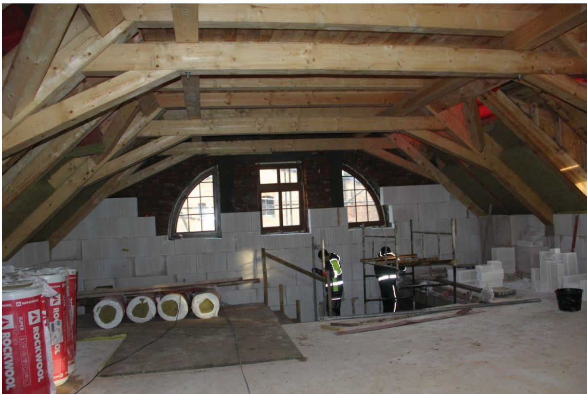
Fot. 12. Na piętrze wydzielona jest strefa przeciwpożarowa, przy klatce schodowej.
