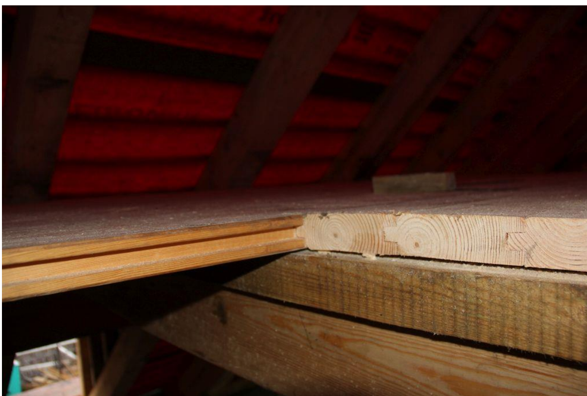
Fot. 16-17. Widok na górną część więźby dachowej. Między kondygnacjami znajdują się deski na pióro-wpust.
