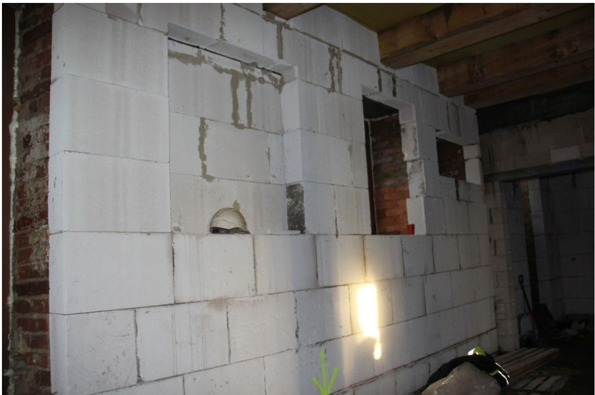
Fot. 7-8. Wewnątrz obiektu na murach wewnętrznych wykonano ocieplenie z płyt izolacyjnych Multipor, według projektu.
