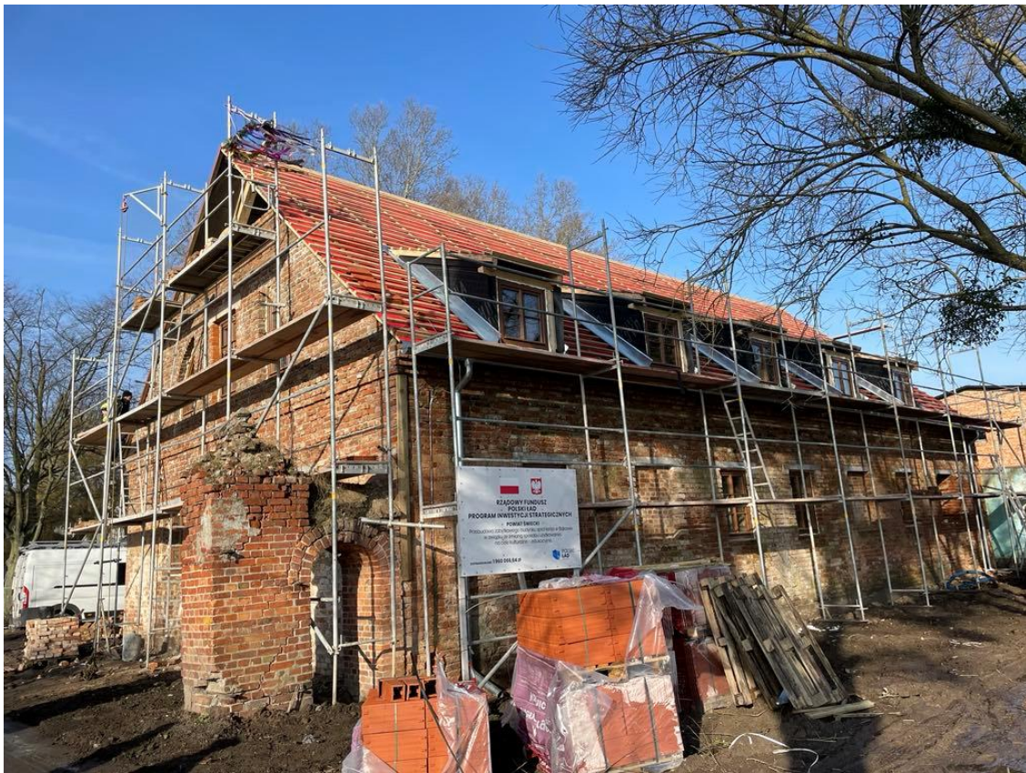
Fot. 3-4. Trwają prace przy murowaniu szczytu południowego oraz północnego.
