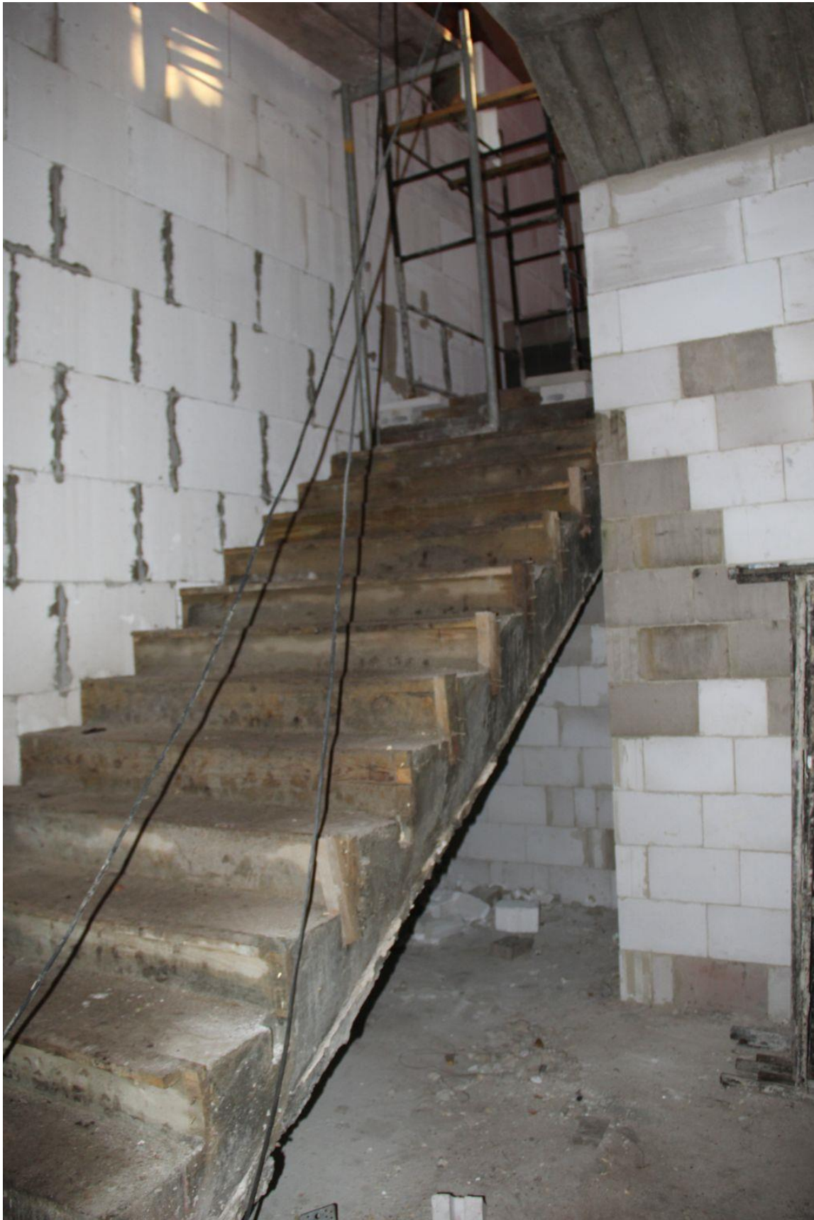
Fot. 11. Na klatce schodowej między parterem a piętrem wykonano schody.
