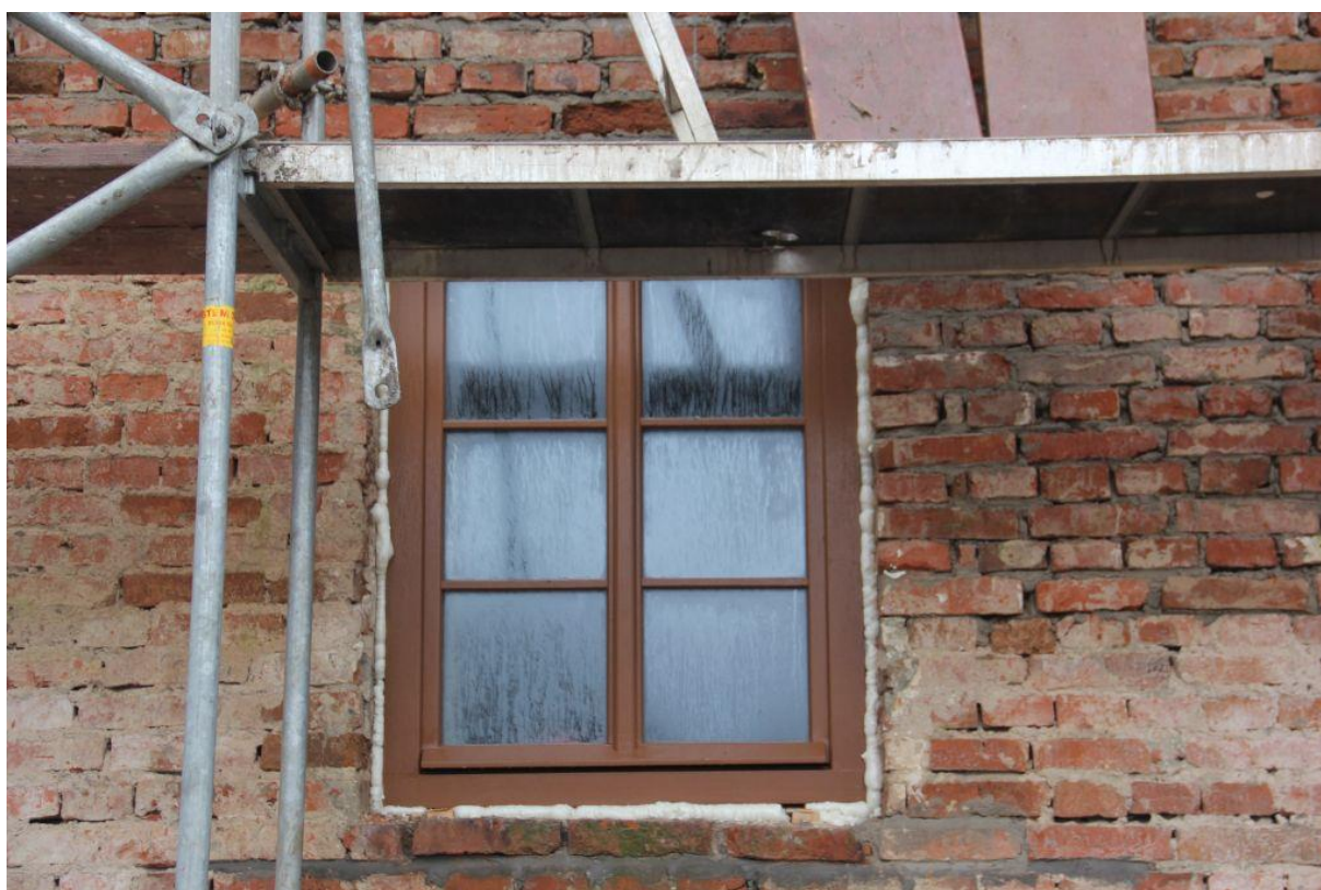
Fot. 22-23. W oryginalne otwory okienne zostały wstawione okna według zatwierdzonego projektu. Kolor okien i drzwi ustalony był podczas komisji w 2023 roku.
