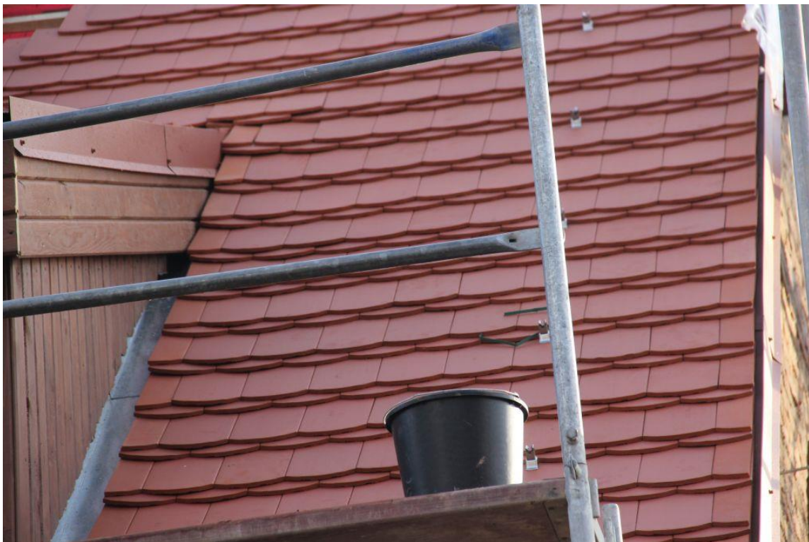
Fot. 1-2. W chwili obecnej trwają prace związane z położeniem dachówki karpówki (w koronkę) na budynku spichrza. Dachówki zamówione zostały z różnych partii, aby położone tworzyły melanz na dachu.
