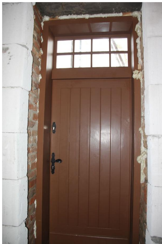
Fot. 18-21. Wykonano i wstawiono nowe drzwi, które były wzorowane na drzwiach zastanych.
