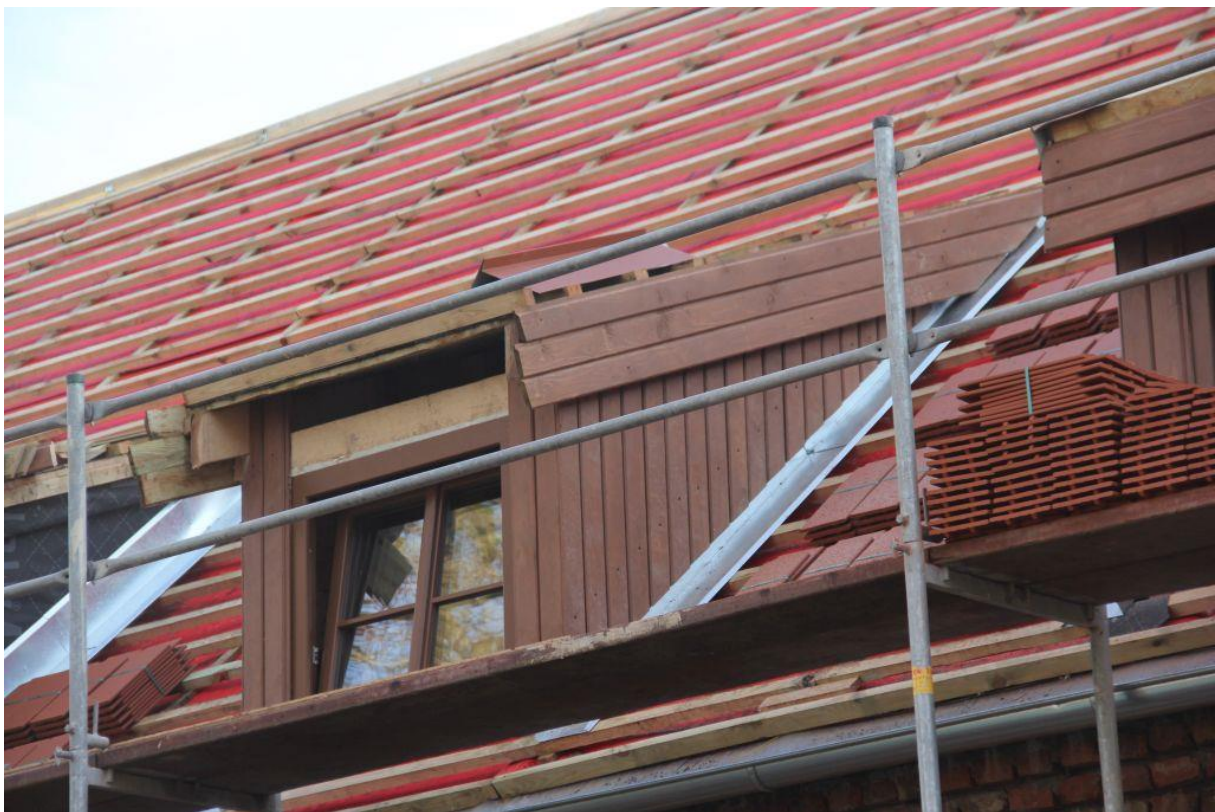
Fot. 24-25. Na dachu wykonywane są lukarny według projektu.
