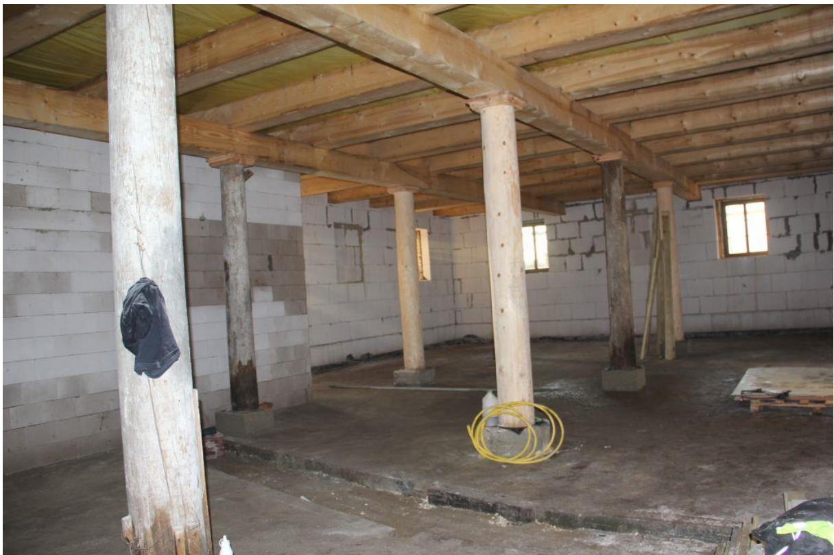
Fot. 9-10. Nowo wstawione kolumny drewniane zostały oszlifowane, aby miały taką samą średnicę przy głowicy jak kolumny oryginalne.
