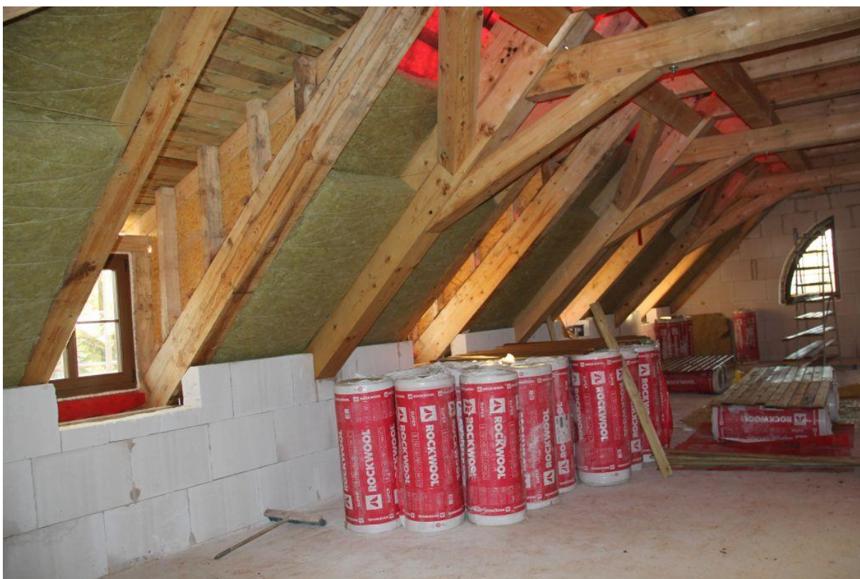
Ot. 13. W chwili obecnej trwają prace związane z ociepleniem poddasza wełną mineralną.
