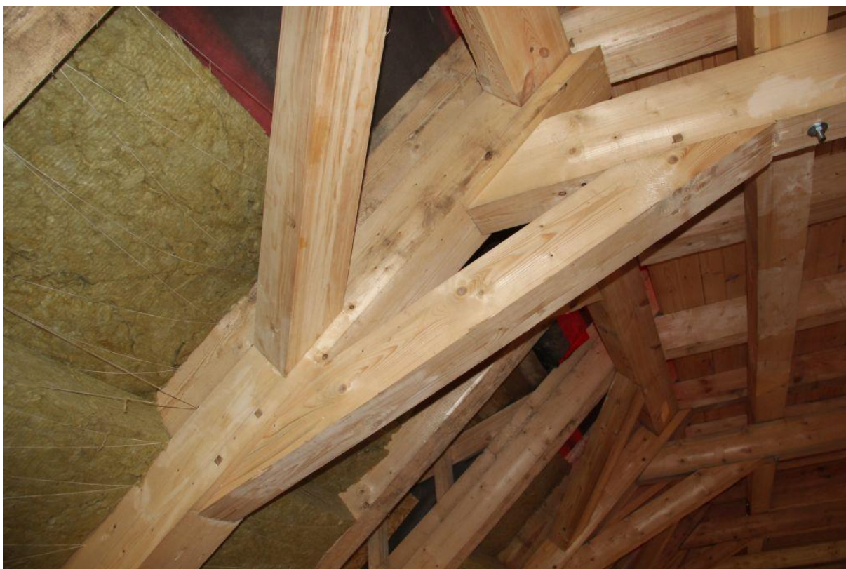
Fot. 14-15. Więźba dachowa została wykonana na wzór oryginalnej więźby. Drewno zostało zaimpregnowane.
