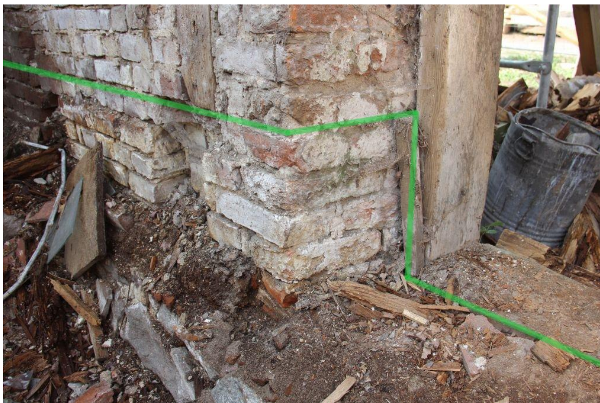
Fot. Na zdjęciach kolorem zielonym zaznaczony oryginalny poziom podłogi ze stopniem.
