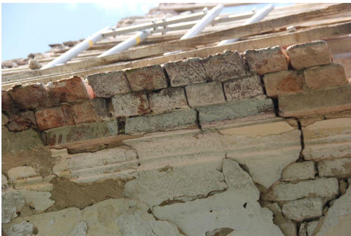
Fot. Widoczny fragment profilu oryginalnego gzymsu.
