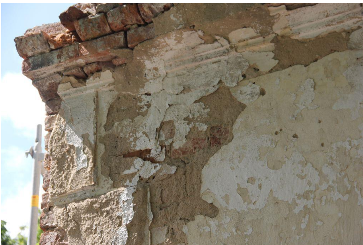
Fot. Widoczny fragment oryginalnych boniowań.
