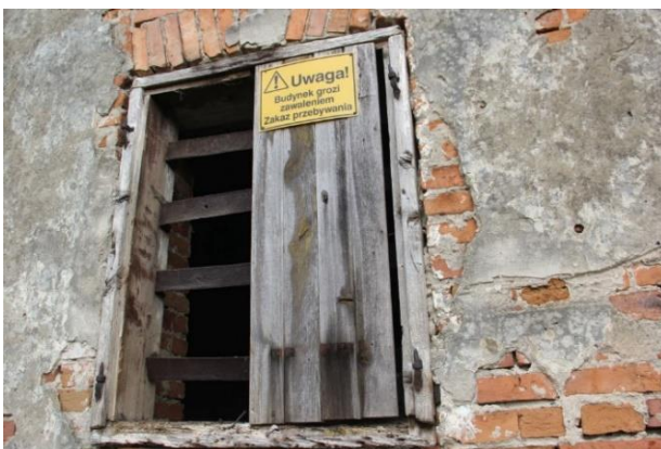
Fot. 25-29. Zachowane oryginalne ościeżnice w otworach okiennych oraz okienice na zawiasach.
