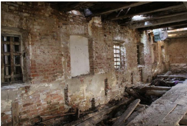
Fot. Stan zachowania wnętrza spichrza w 2021 r.
