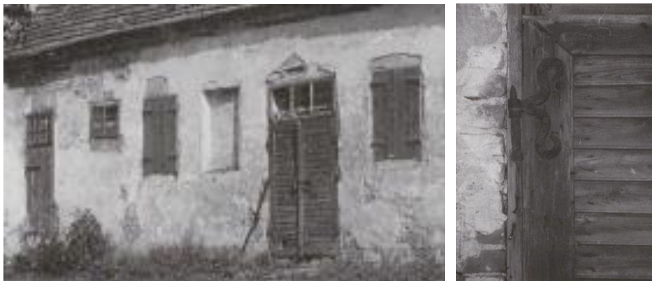
Fot. Zdjęcie obrazujące oryginalne drzwi spichrza oraz okucia drzwi głównych.
