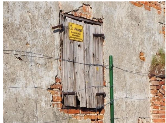
Fot. 25-29. Zachowane oryginalne ościeżnice w otworach okiennych oraz okienice na zawiasach.
