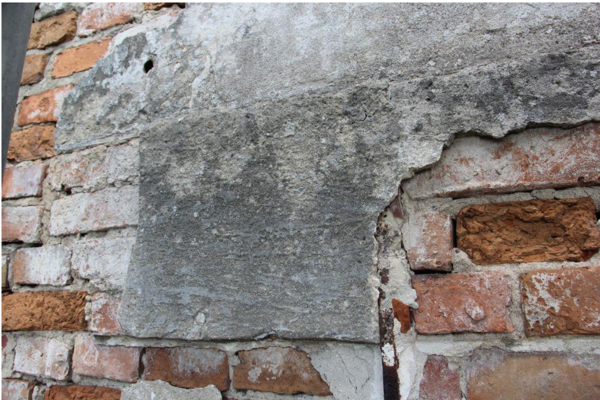
Fot. Widoczny fragment oryginalnego pasa między kondygnacjami w elewacji południowej.
